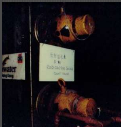
Sewage level control ^{137}\text{Cs} : 20 MBq x 2
